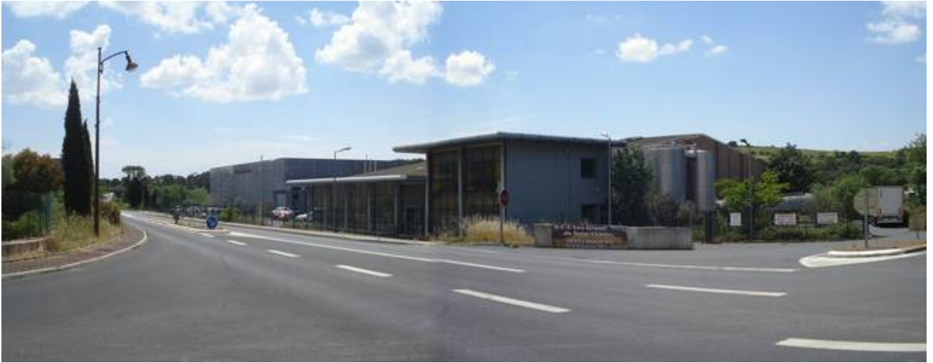
1- Vue du site depuis la RD 612 côté Nord
