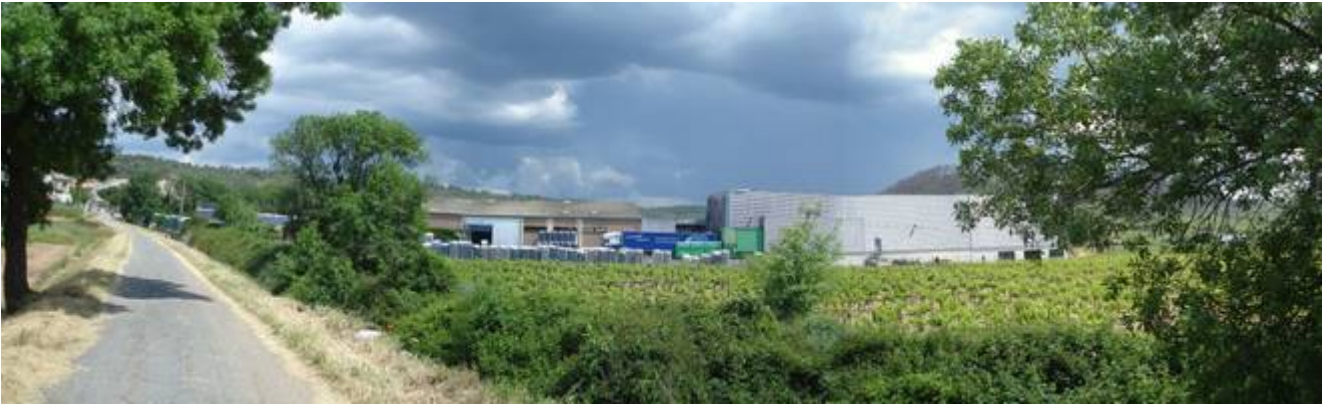
3- Vue depuis le chemin côté Sud
